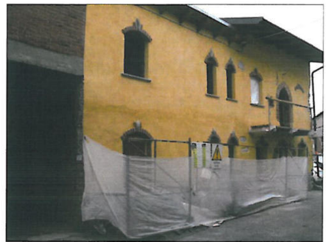
19) vista 1, fronte strada
