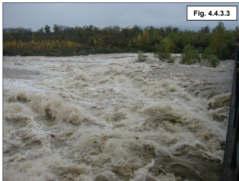
T. Stura di Lanzo in piena (06/11/2011 ore 13, vista verso valle)
