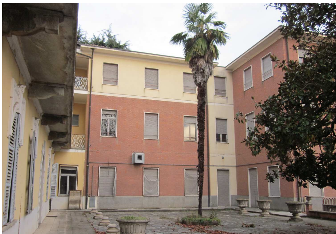
Corpo aggiunto negli anni '60, prospetto ovest a 3 piani f.t.
