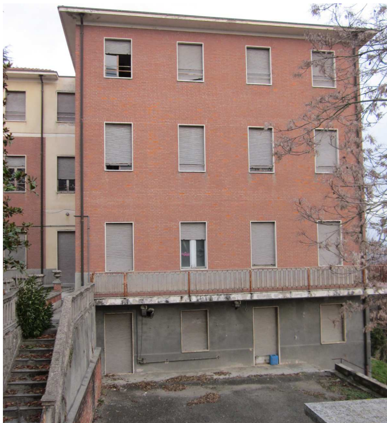
Corpo aggiunto negli anni '60, prospetto ovest a 4 piani f.t.
