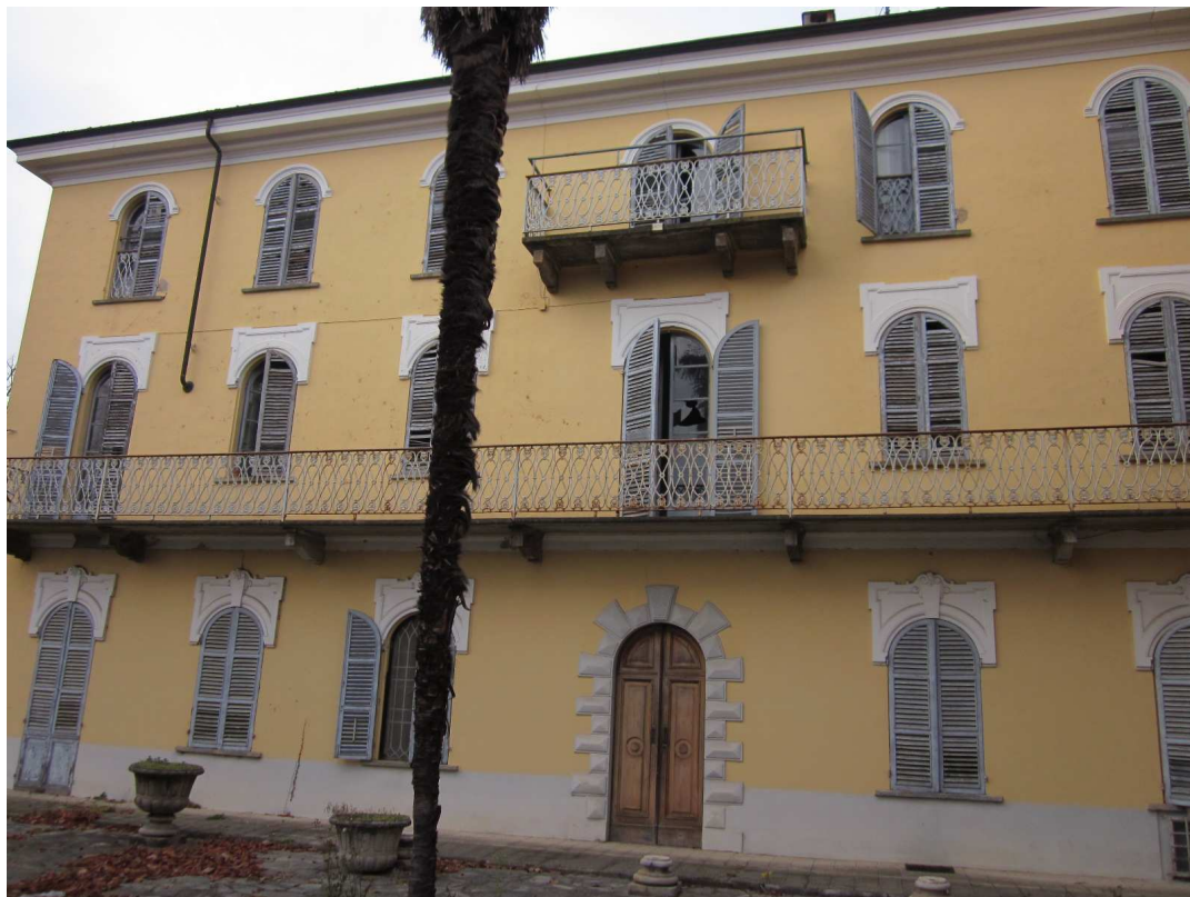
Edificio originario di inizio '900, prospetto sud
