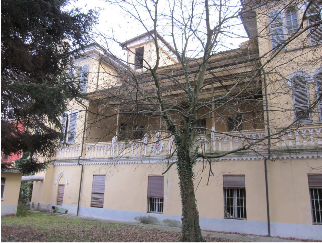
Edificio originario di inizio '900, prospetto nord
