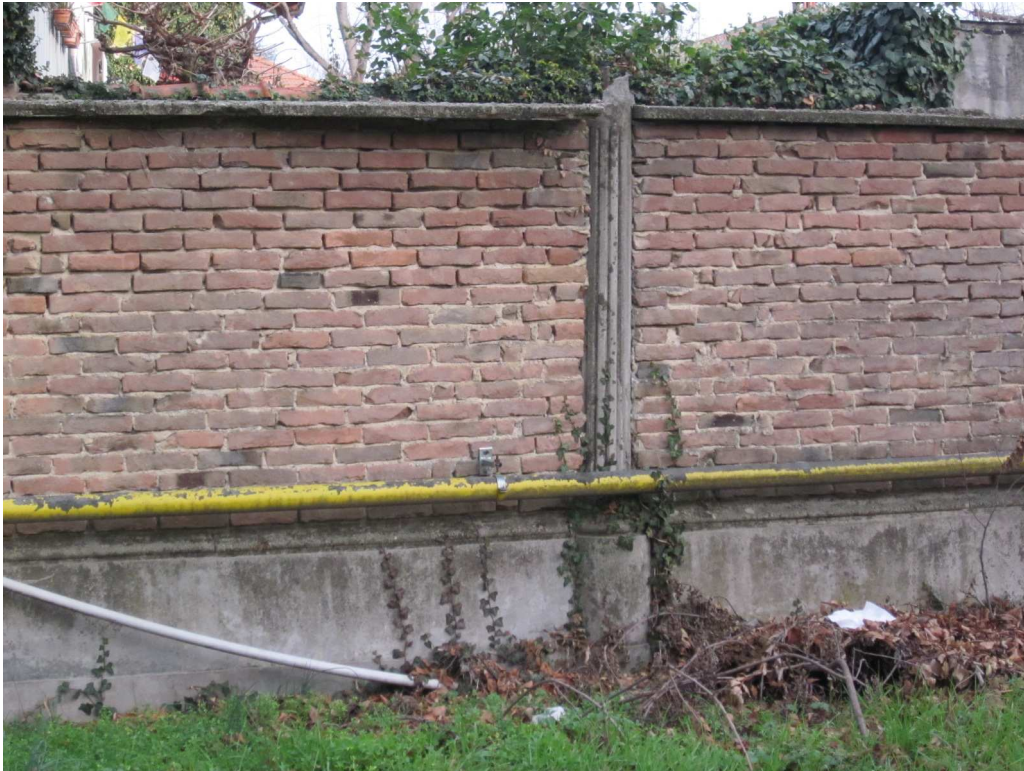
Particolare del muro di cinta con basamento in cemento e sovrastanti mattoni racchiusi tra pilastri in cemento armato
