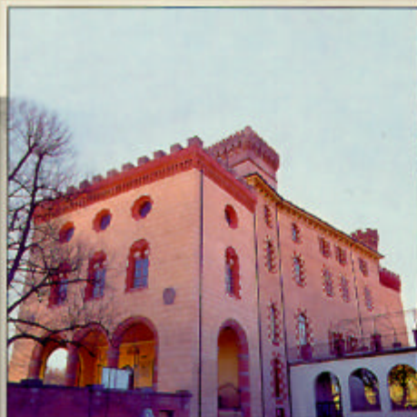
Castello di Barolo (CN) - Realizzazione dei serramenti "in stile".
