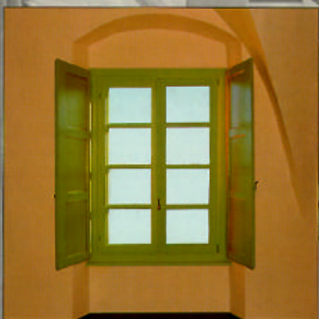
Finestra con scuretti interni. Trattamento con vernici ecologiche.
