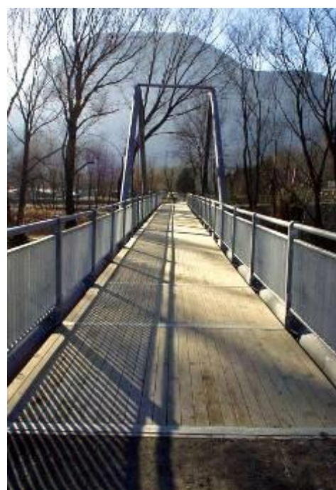
4 c) Passerella in ferro zincato con pavimentazione in doghe di legno, Canneti di Fondotoce
