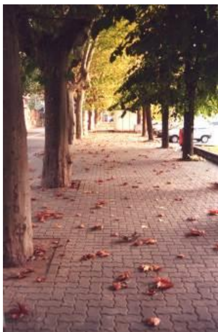
1.10 a) Pavimentazione in masselli di calcestruzzo posati in diagonale e a correre con bordure a scacchiera, di formato diverso, nei colori grigi e rosso, piazza Salvo D'Acquisto, Borgomanero
