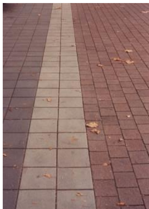
1.10 a) Pavimentazione in masselli di calcestruzzo posati in diagonale e a correre con bordure a scacchiera, di formato diverso, nei colori grigi e rosso, piazza Salvo D'Acquisto, Borgomanero
