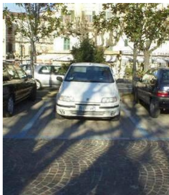
7 b) Area a parcheggio realizzata con pavimentazione mista in masselli autobloccanti di cemento colorato e cubetti di porfido ad archi contrastanti, Intra
