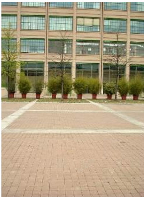
7 a) Area a parcheggio realizzata con pavimentazione mista in masselli autobloccanti e lastre di cemento colorato Lingotto, Torino
