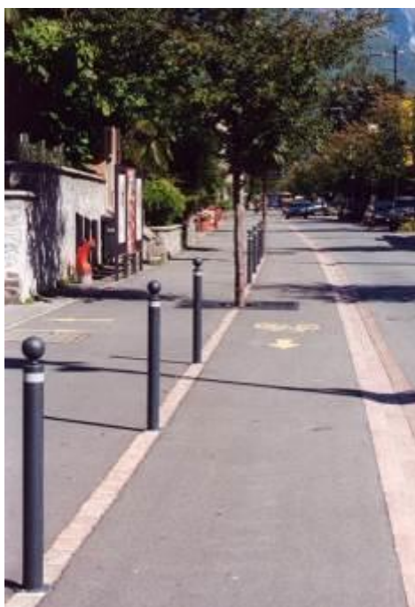
6.3 b) Dissuasori verticali in metallo verniciato con nastro rifrangente Ascona, Svizzera
