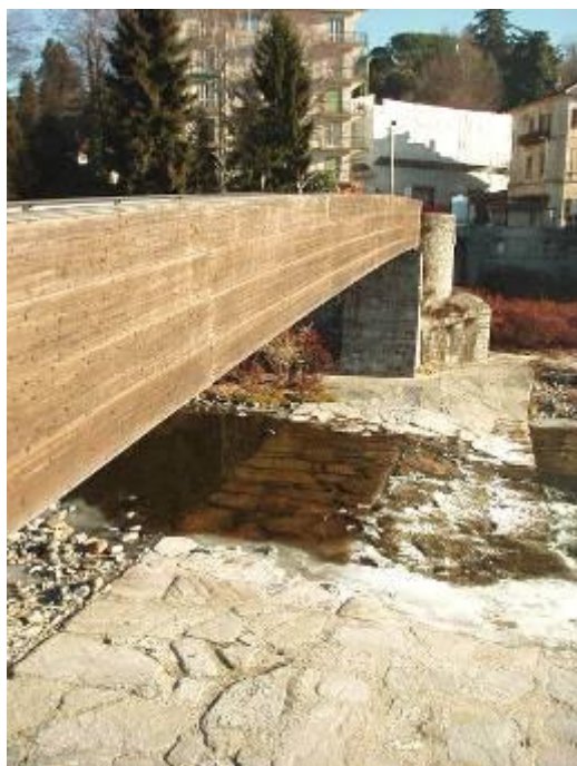
4.1 b) Parapetto e struttura portante in legno lamellare Verbania
