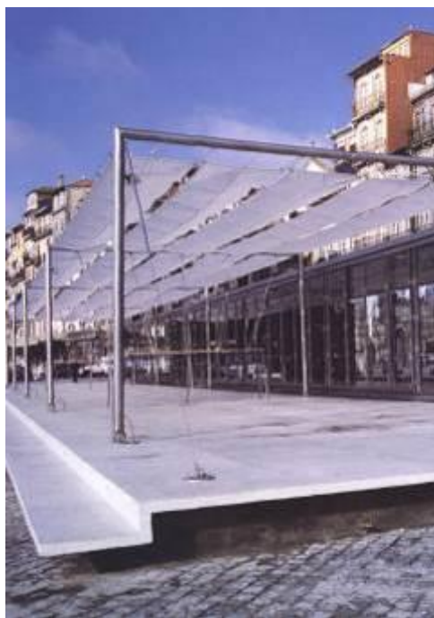
4.3 b) Struttura fissa di metallo con copertura di tessuto Café do Cais, Oporto, Portogallo
