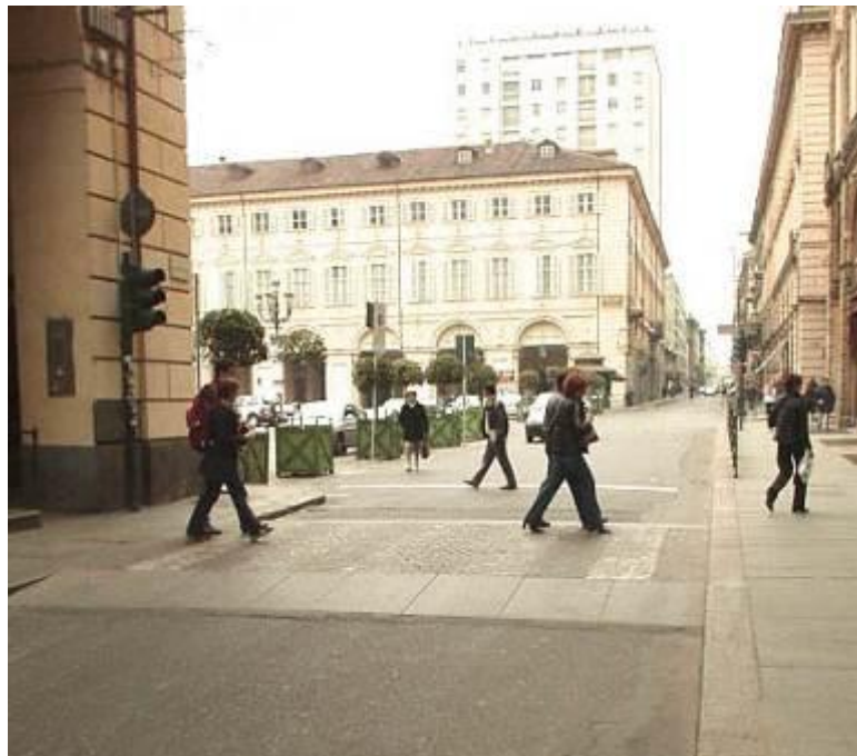
4 a) Attraversamento pedonale su plateau rialzato realizzato in lastre e blocchetti di pietra Piazza S. Carlo, Torino
