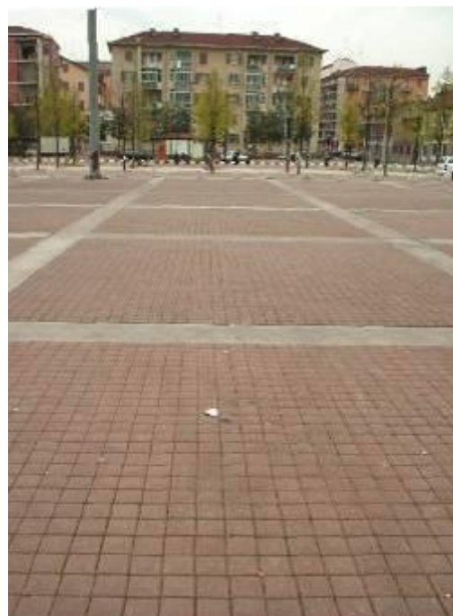
7 a) Area a parcheggio realizzata con pavimentazione mista in masselli autobloccanti e lastre di cemento colorato Lingotto, Torino
