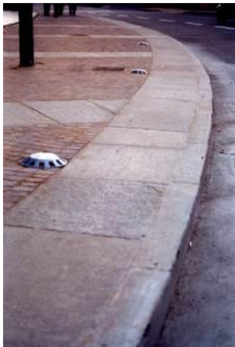
1.4 a) Lampade carrabili da incasso a terra Verbania
