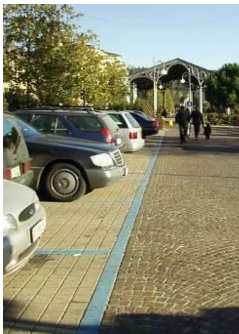
7 b) Area a parcheggio realizzata con pavimentazione mista in masselli autobloccanti di cemento colorato e cubetti di porfido ad archi contrastanti, Intra
